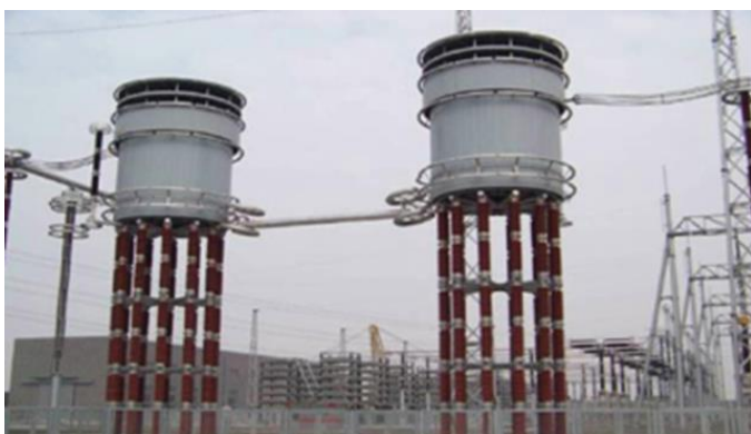
Сухой сглаживающий реактор 800 кВ
