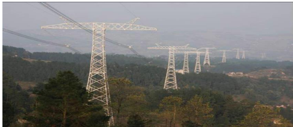
Воздушная ЛЭП ±800 кВ
