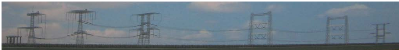
Четырехполюсная опытная воздушная линия постоянного тока УВН
