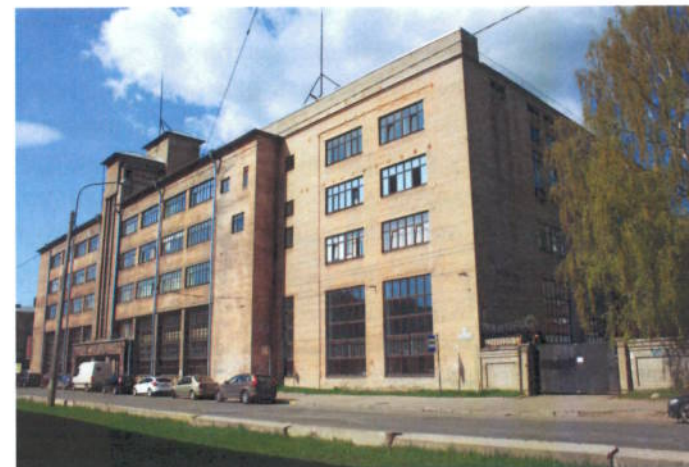
Рис. 2. Современный вид 2-го корпуса НИИПТ со стороны Физико-технического института
