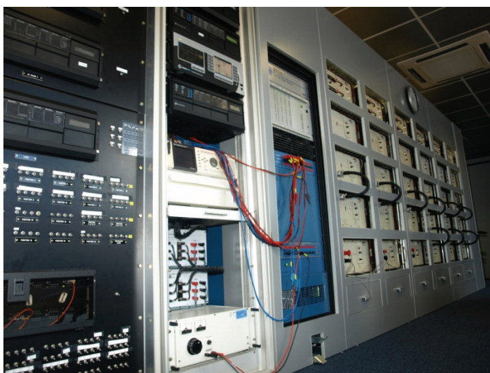
Рис. 4. Установка RTDS (Multilin, Бильбао, Испания)
