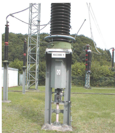
Рис. 3: Кабельный вывод и ТТ
