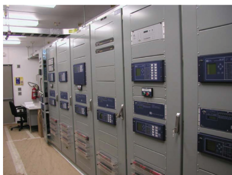
Рис. 6: Несколько интеллектуальных и автоматизированных устройств заменяют множество дискретных элементов
