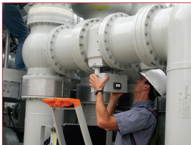
Рис. 6: Реальная установка нетрадиционного измерительного трансформатора типа Роговского на распределительное устройство с элегазовой изоляцией
