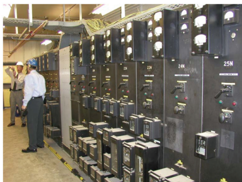
Рис. 5: Многие дискретные элементы не обеспечивают расчетов, памяти и возможностей связи, необходимых для интеллектуальной работы
