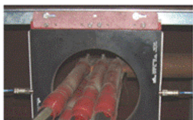
(a) Катушка Роговского, смонтированная вокруг 6 проводников
